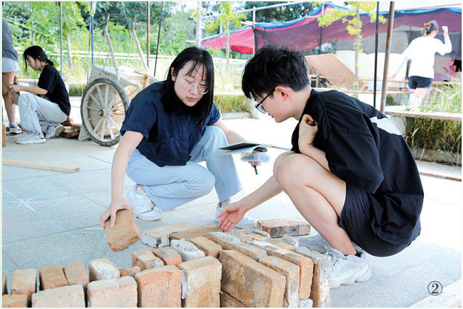
8月9日,香港大学20多名师生在陕州区张汴乡西王村一座地坑院改造现场,实施香港大学地坑院设计建造工作营项目。 在建设过程中,香港大学建筑学院将分批招募大学生参与设计和建造,让他们在实践中收获真知。据了解,该项目一期改造1座地坑院,投资100多万元,建成之后将作为村民活动中心和香港大学教研基地。 图①正在改造中的地坑院 图②大学生在尝试砖柱的排列方法
