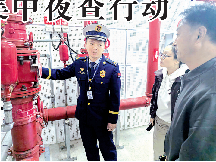
图为检查组对消防设施进行检查。 灵宝市消防救援局提供
