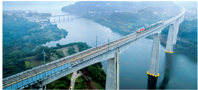
10月20日,检测车行驶在渝万高铁线路上(无人机照片)。10月20日6时20分许,随着检测车从重庆东站驶出,渝万高铁启动联调联试,进入工程验收关键阶段,为全线早日开通奠定坚实基础。渝万高铁是我国“八纵八横”高铁网包(银)海、京昆通道的重要组成部分,也是沿江高铁通道的重要补充。正线全长约254公里,设计时速350公里。
