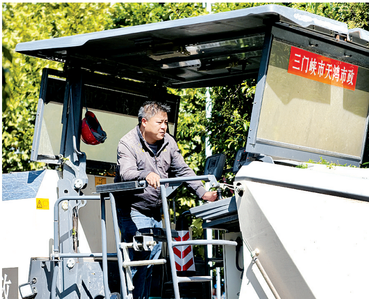
建设者加紧道路施工，夯实城市民生基础。
