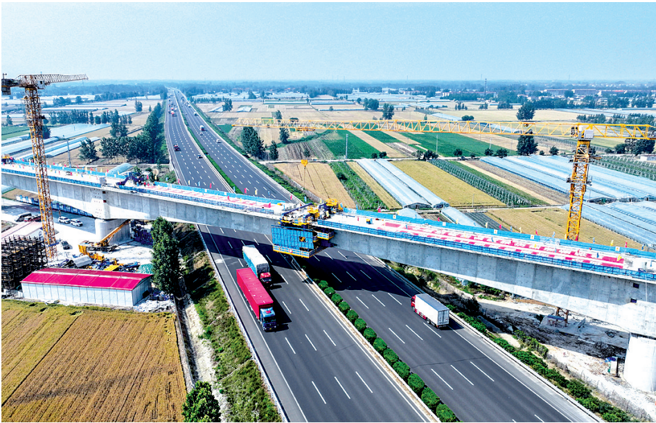
这是5月31日拍摄的潍宿高铁山东省临沂市郯城县跨京沪高速连续梁合龙后的画面(无人机照片)。 5月31日，由中铁上海局承建的潍(坊)宿(迁)高铁山东省临沂市郯城县跨京沪高速连续梁顺利合龙，标志着全线重难点控制性工程取得突破性进展，为后续梁架、铺轨作业奠定坚实基础。 新华社记者 郭绪雷 摄
