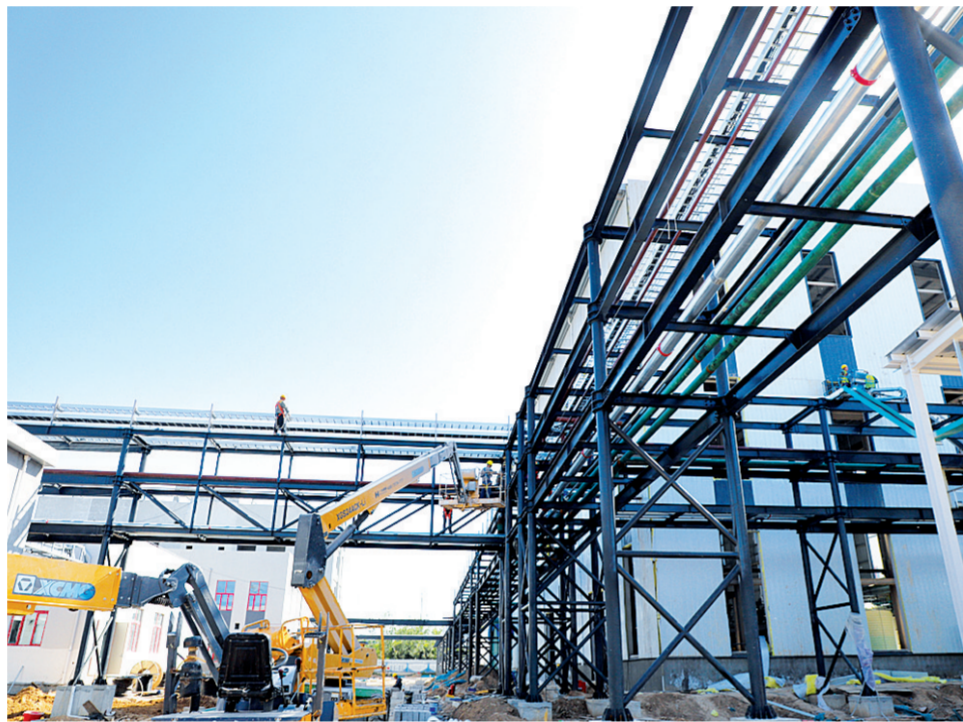
5月9日,在市城乡一体化示范区(高新区)河南金梁铝业年产6000吨高纯铝产品项目建设现场,工人正加紧施工。 据悉,该项目依托赵中伟院士团队研发的无氟铝冶炼新技术,主要生产高纯氧化铝、三氯化铝和铝粉等产品,广泛应用于电子信息、平面显示、清洁能源、化工催化等高新技术行业,项目建成达产后将实现年产值约12亿元、利税约6000万元。自项目开工以来,各环节有条不紊推进,科学管理,倒排工期,力争早日建成达产。 本报记者 徐洪波 摄
