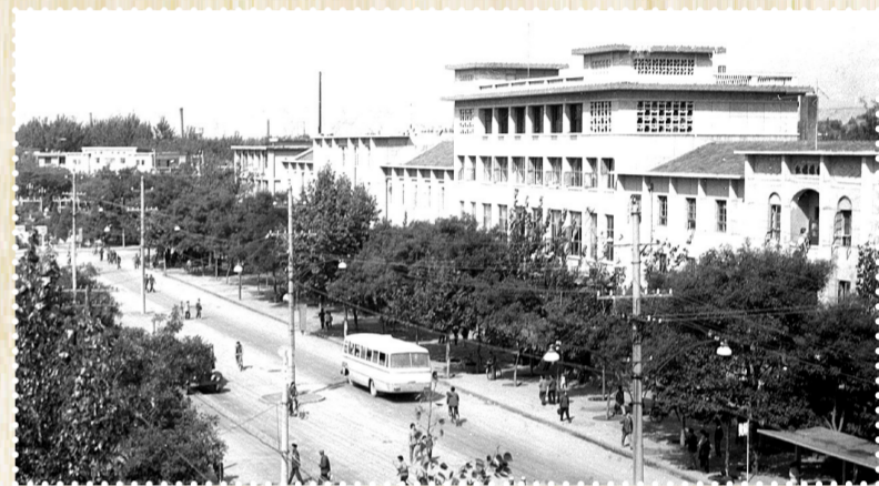
黄河路,始建于1956年。为建设三门峡大坝,建设者在荒芜之地开辟了这条路,1959年竣工,是三门峡市区第一条主干道。黄河路全长7.85公里,东起三门峡火车站,西至陕州公园。黄河路曾有许多“顶流”地标,如百货大楼、新华书店、黄河饭店等,是承载城市发展、鼎盛繁华与生活记忆的“活历史”。图为20世纪80年代的黄河路。
