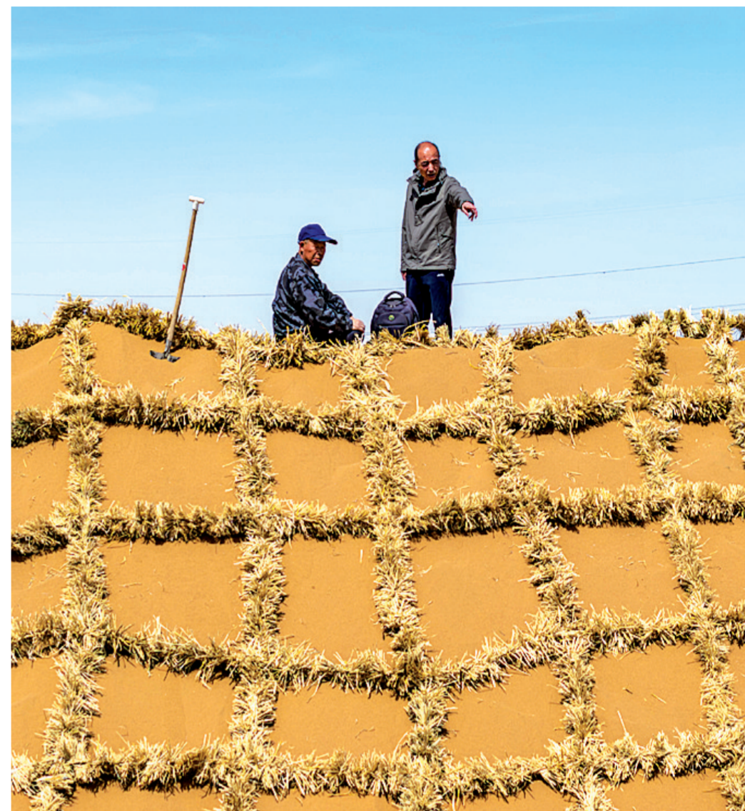
唐希明(右)在位于宁夏中卫境内的腾格里沙漠东南缘指导工人铺设刷状网绳式草方格(2026年4月10日摄)。 新华社记者 王鹏 摄
