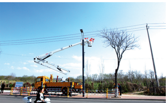
供电人员借助带电作业机器人完成故障指示器带电加装作业
