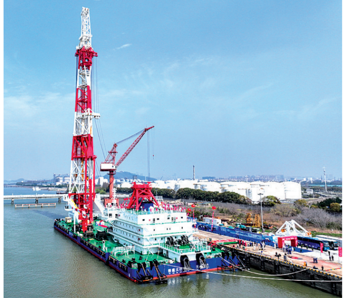
3月31日在江苏南通拍摄的156米动力定位打桩船“铁建大桥桩1号”(无人机照片)。
