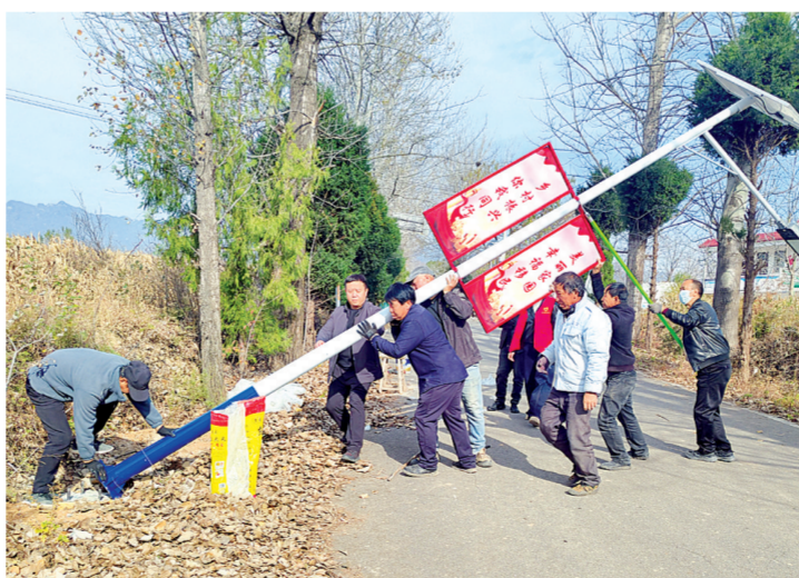
安装太阳能照明灯
