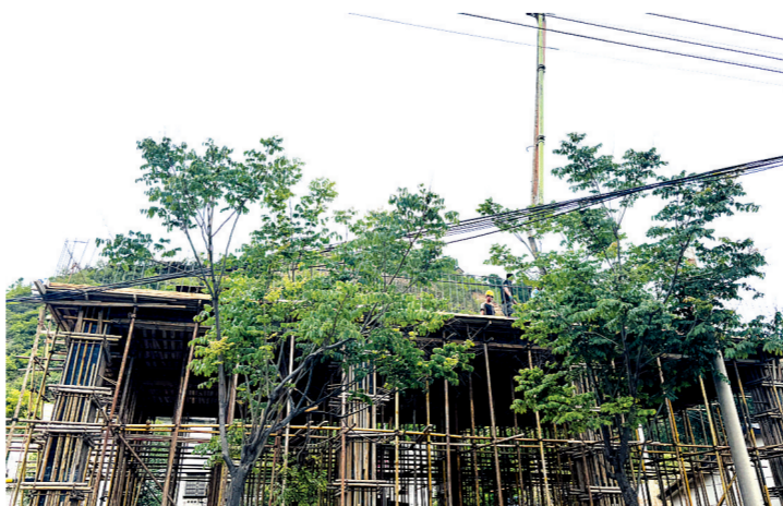
民生工程加快施工
