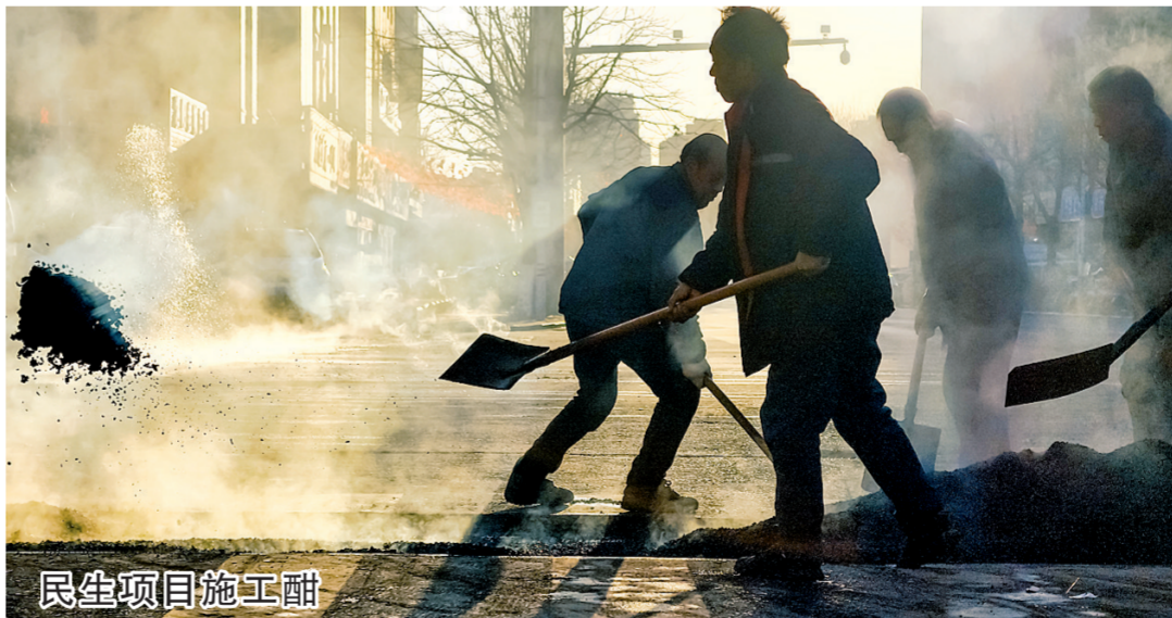
1月12日,在卢氏县迎宾路地下管网改造工地,机车轰鸣,烟雾缭绕,工人们忙着施工,鏖战一季度民生建设项目,呈现出一派新年奋进的繁忙景象。 聂金锋 摄
