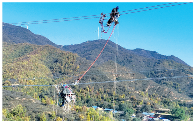
供电工人安装间隔棒。李斌 摄
