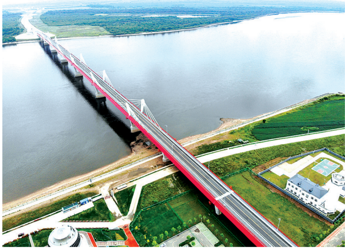
这是2023年8月11日在中国黑河一侧拍摄的黑河—布拉戈维申斯克公路桥(无人机照片)。
