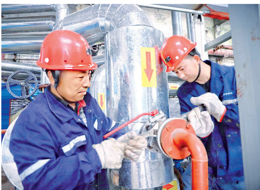
连日来,河南能源义煤公司常村煤矿党委多维发力办实事、主动服务送关怀,全方位护航矿井安全稳定。图为11月4日,该矿后勤中心检修工对改造后的暖气交换站进行供暖前试压、紧固阀门,用细致检修筑牢暖气防线,保障矿区供暖无忧。吴美莲 摄
