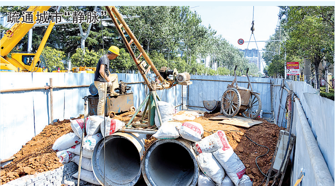
目前正是“七下八上”防汛关键期,渑池县采取有效措施积极应对,对城区会盟路、双拥路等主干道的污水管道进行升级改造。图为8月2日,施工人员正在规范安装管道。
