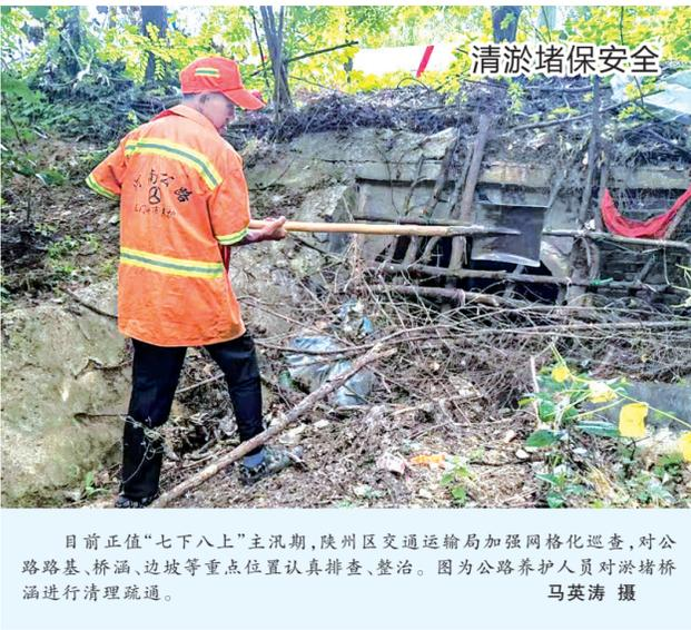
目前正值“七下八上”主汛期,陕州区交通运输局加强网格化巡查,对公路路基、桥涵、边坡等重点位置认真排查、整治。图为公路养护人员对淤堵桥涵进行清理疏通。 马英涛 摄
