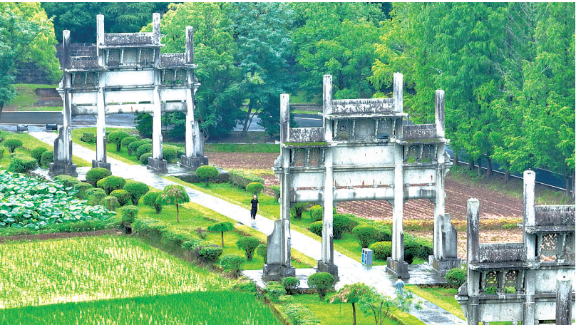
6月19日,周虎在位于歙县的全国重点文物保护单位棠樾牌坊群巡查(无人机照片)。
