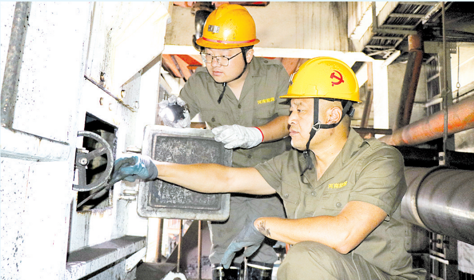
→6月20日,义煤公司耿村煤矿洗煤厂重介车间班组长在检查洗选设备运行情况。
