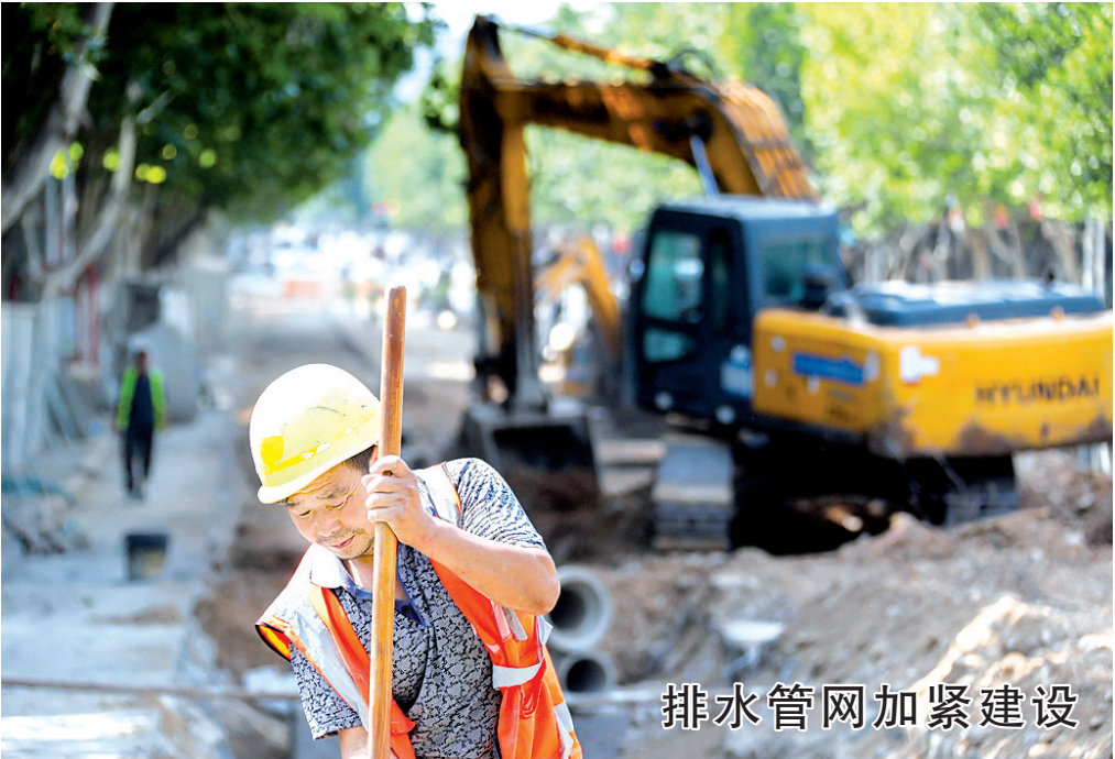
今年以来,卢氏县加紧推进排水管网建设,提升城市排水防涝能力和水平,保障人民群众生命财产安全。图为近日,该县文明路管网建设工地上机车轰鸣,工人正在开挖路面,铺设管网。
