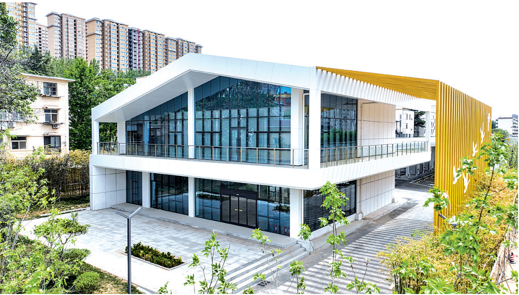
充电站还设置了能源管理中心。
