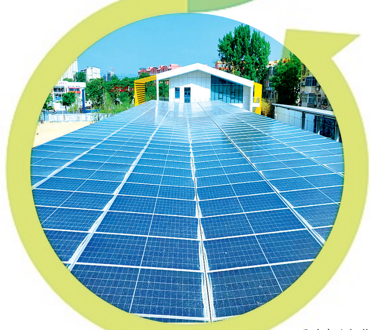
通过光伏板构建分布式发电网络，满足站内用电需求。
