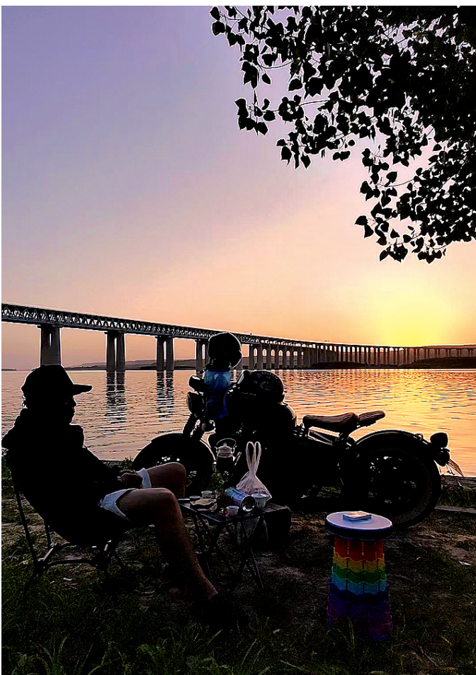
浩吉铁路三门峡黄河公铁两用大桥倒映在春水之上,美景无限,吸引游客露营、打卡。本报记者 许爱珍 摄
