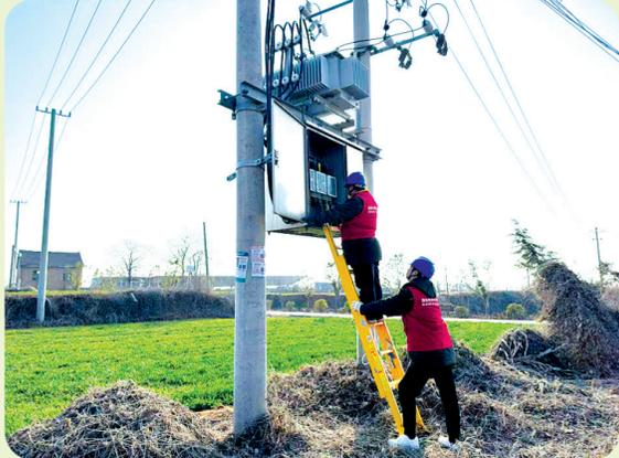
为保障春耕用电,日前,国网三门峡供电公司工作人员对辖区机井农排台区变压器进行电压测量。
