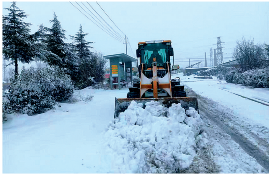
渑池县交通运输局农村公路部门出动铲雪车清理路面积雪 邵娟 摄
