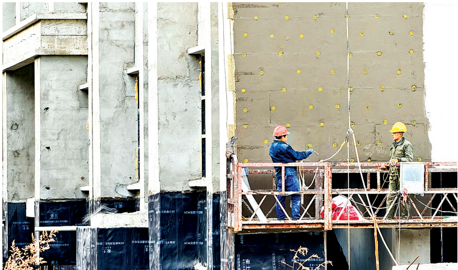
卢氏莘川坊特色商业区建设工地,工人们忙着铺装外墙保温层。李东阳 摄
