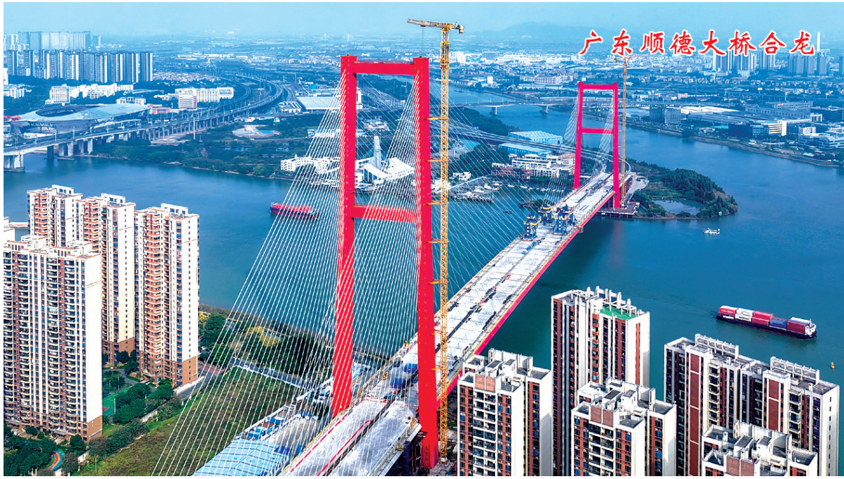
顺德大桥横跨容桂水道，连接顺德容桂与大良两个街道(12月24日报，无人机照片)。
