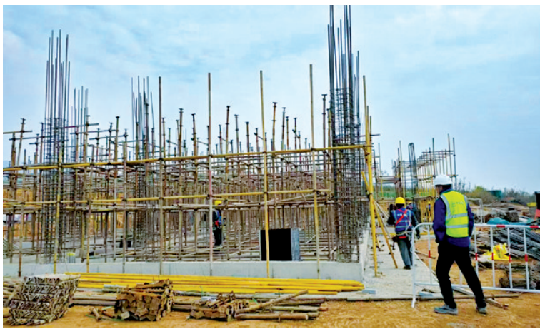
风电项目升压站建设施工中
