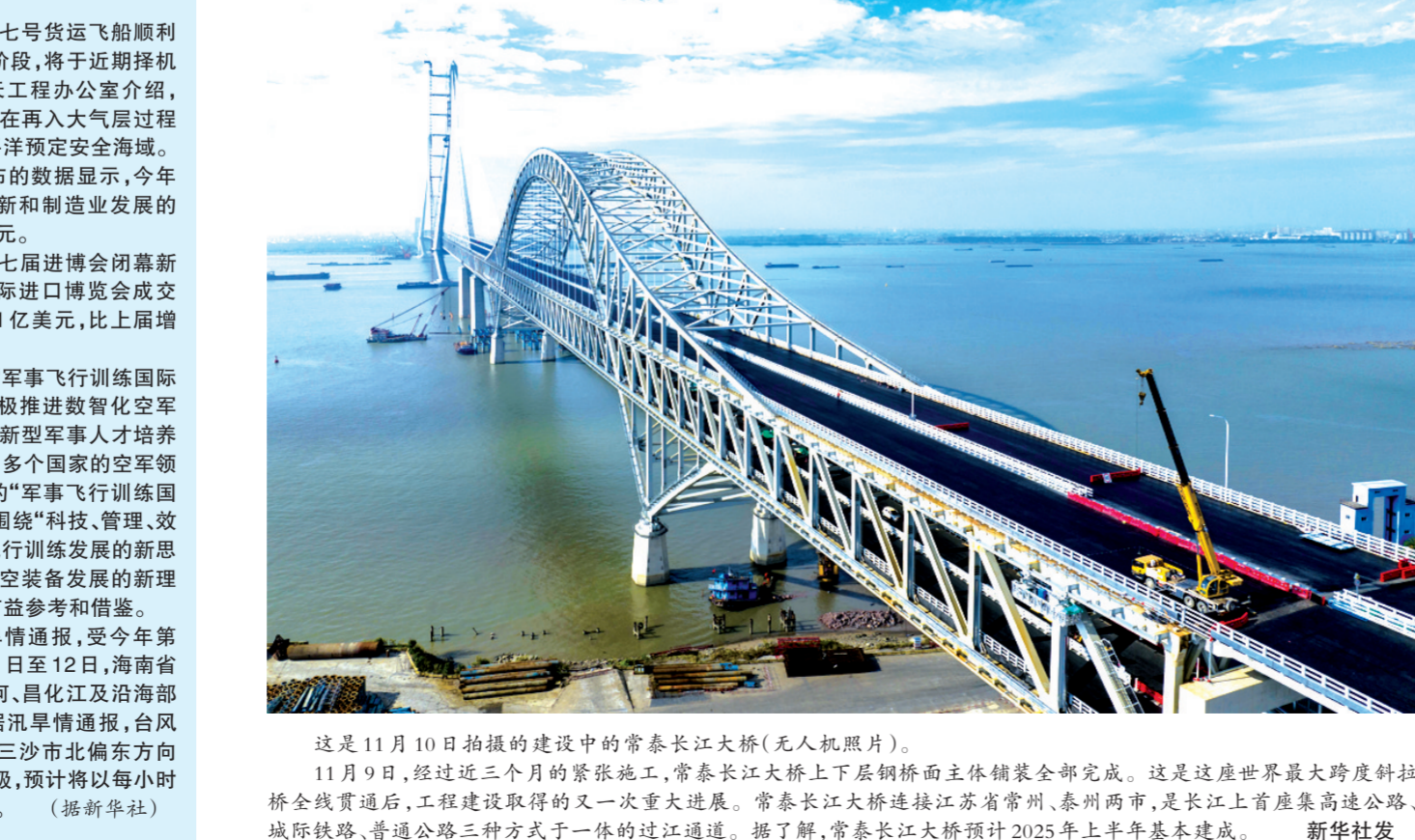
这是11月10日拍摄的正在建设的常泰长江大桥(无人机照片)。11月9日,经过近三个月的紧张施工,常泰长江大桥上下层钢桥面主体铺装全部完成。这是这座世界最大跨度斜拉桥全桥贯通后,工程建设取得的又一次重大进展。常泰长江大桥连接江苏省常州、泰州两市,是长江上首座集高速公路、城际铁路、普通公路三种方式于一体的过江通道。据了解,常泰长江大桥预计2025年上半年基本建成。新华社发
