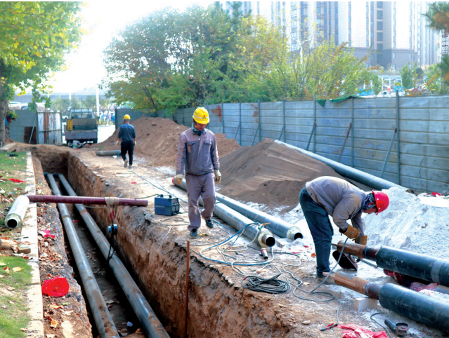
大岭南路供热一级管网紧张施工
