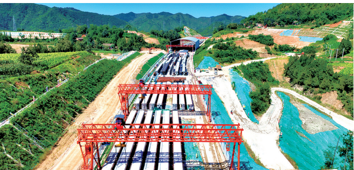
项目施工现场 党维德 摄
