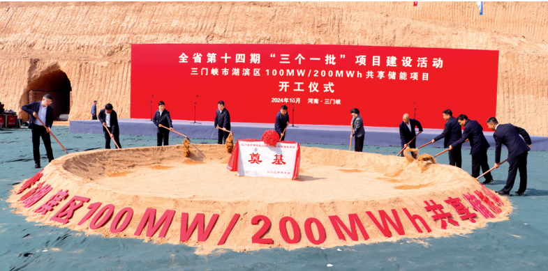
全省第十四期“三个一批”项目建设活动三门峡市湖滨区100MW/200MWh共享储能项目开工仪式
