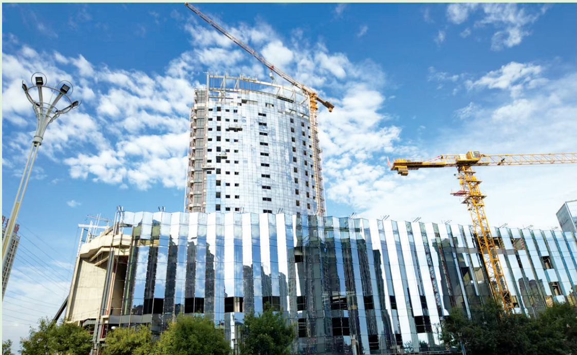
位于现代服务业开发区的工人文化宫项目抓紧建设,将成为城市文化体育新地标。本报记者 孙猛 摄
