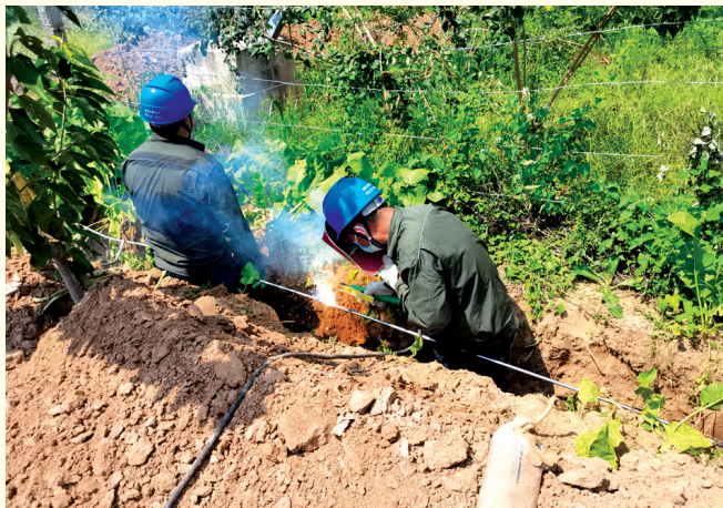
检修人员对锈蚀老化接地网进行更换作业 黄凯 摄
