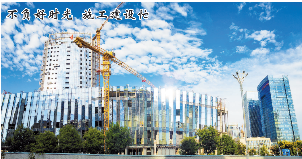
9月9日,一场秋雨过后,天空明镜如洗,市工人文化宫项目建设工地,工人正在对建筑主体加装玻璃。随着该项目的加紧建设,工人文化宫也逐渐显出雄伟身姿,成为我市又一地标性建筑。 本报记者 孙猛 摄
