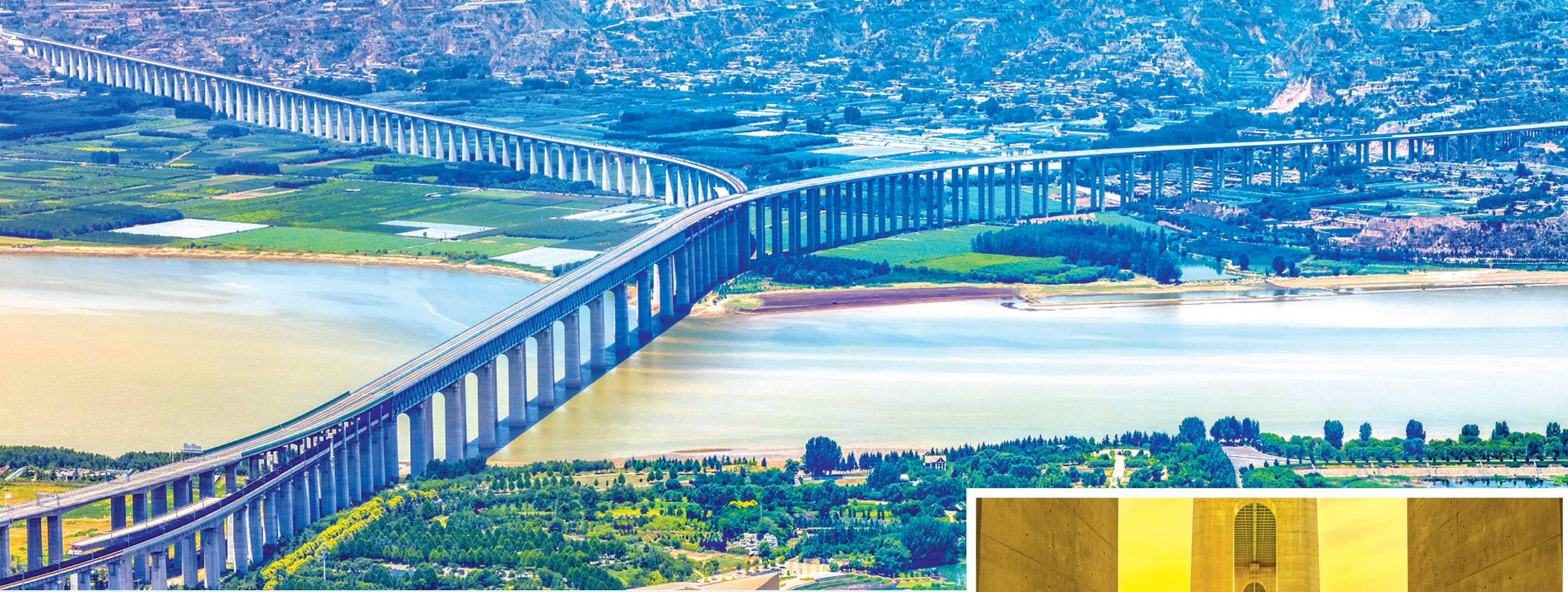
三门峡黄河公铁两用桥
