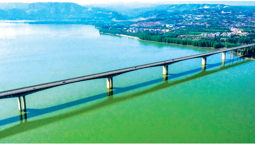
如今的三门峡黄河公路大桥
