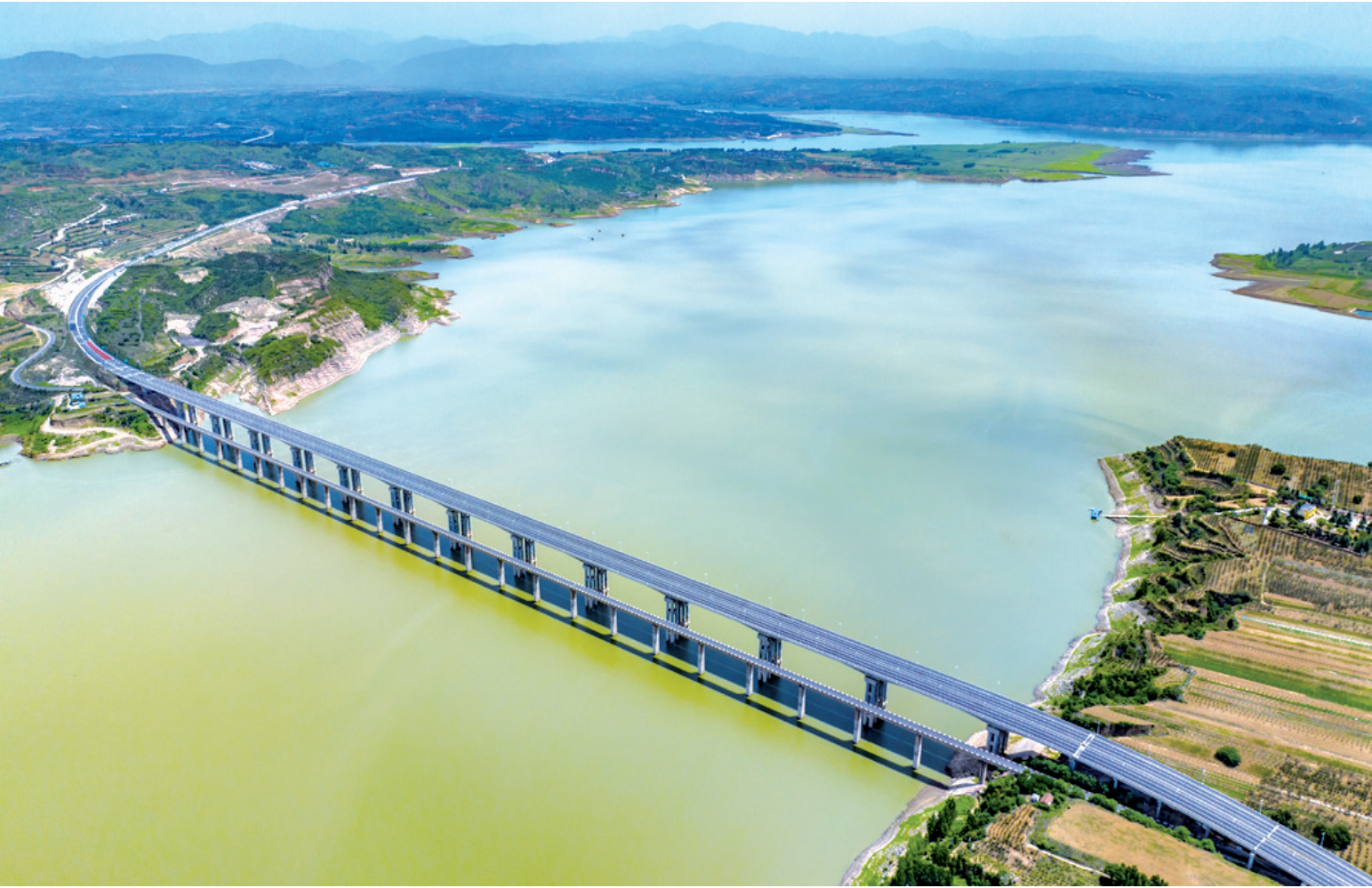
渑池南村黄河公路大桥与绿地南村黄河特大桥“并驾齐驱”
