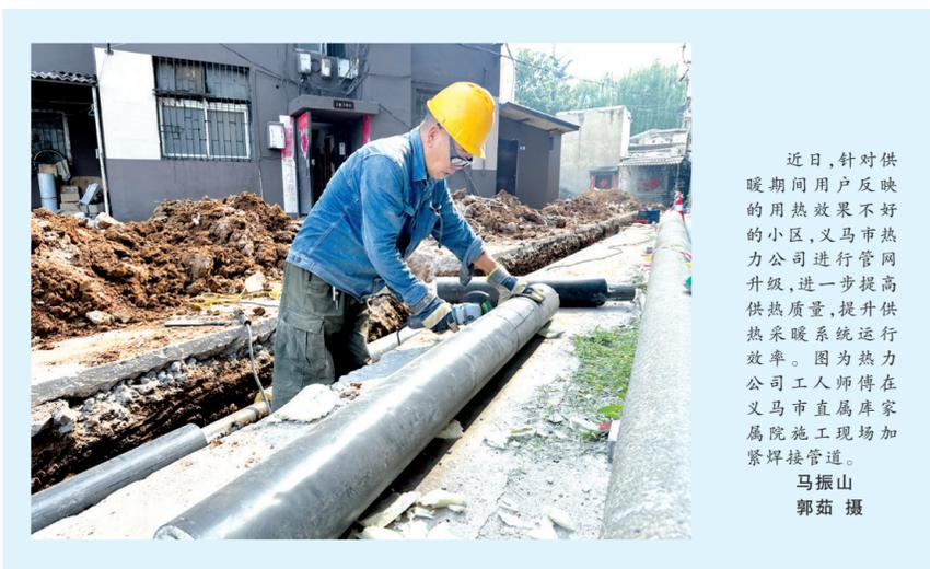
近日，针对供暖期间用户反映的用热效果不好的小区，义马市热力公司进行管网升级，进一步提高供热质量，提升供热采暖系统运行效率。图为热力公司工人师傅在义马市直属库家属院施工现场加紧焊接管道。马振山 郭茹 摄
