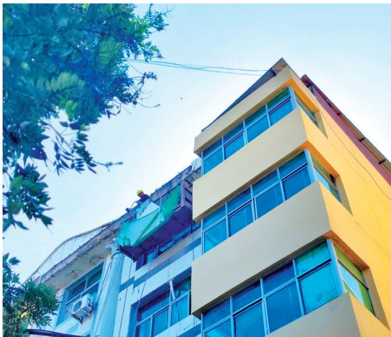
8月27日，在卢氏县城关镇西关社区，工人正在对老旧小区居民楼进行外墙保温施工。近年来，卢氏县持续实施老旧小区改造工程，不断提高群众生活品质。李东阳 摄
