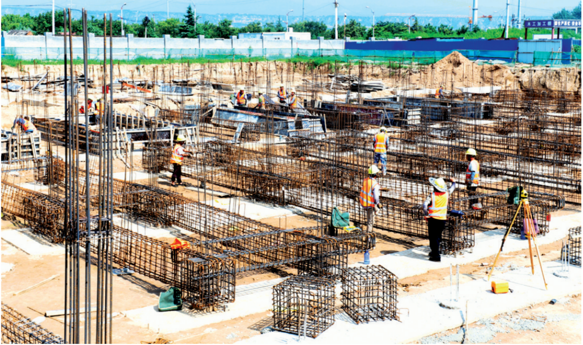
日前，在市城乡一体化示范区（高新区）大唐示范区独立共享储能电站项目施工现场，工人正在紧张施工。该项目一期工程建设规模为100MW/200MWh，拟新建一座220kV升压站，采用屋外封闭式GIS配电装置，为电网运行提供调峰、调频、黑启动、需求响应等多种服务。项目建成后，将进一步优化当地能源供应结构，促进当地经济发展，助力“双碳”目标稳步实现。 本报记者 徐洪波 摄
