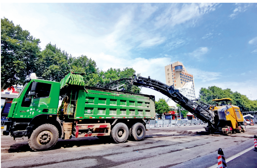
紧张有序施工 本报记者 陈海洋 摄
