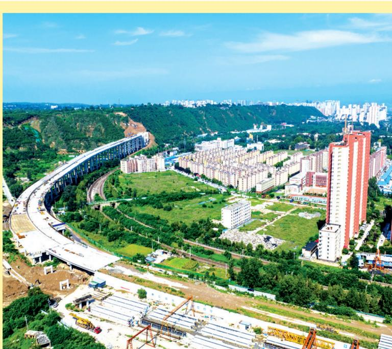
7月31日,建设中的三门峡崤山大道第二标段项目工地。该标段主线设计长6.961公里,沿现代服务业开发区规划道路线继续向东展线,利用高架桥跨越青龙涧河与东风路相接,其中大桥4座、互通立交1座、匝道桥1座,全线通车后将进一步完善城区交通路网,提升城市综合承载能力。本报记者 孙猛 摄
