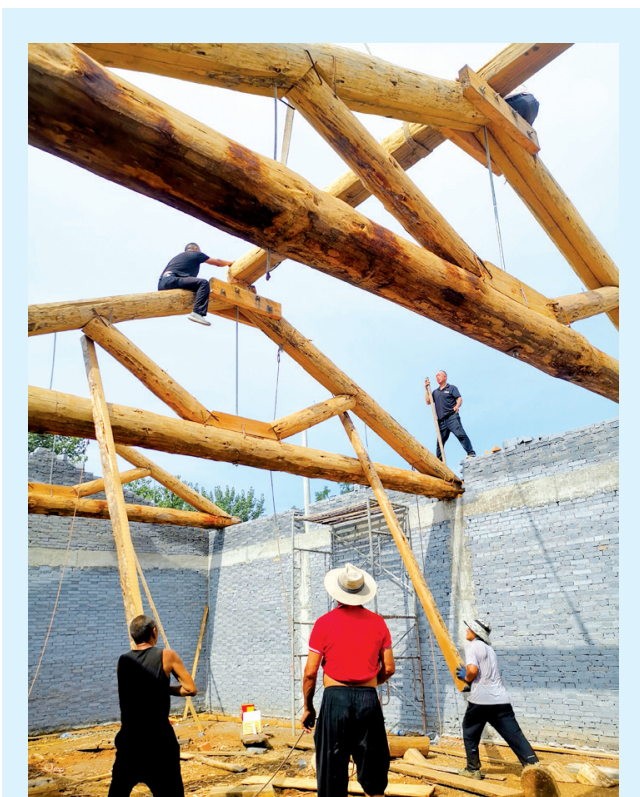
7月25日,在“中共豫西二地委渑池纪念馆”旧址修复工地,工人们加紧施工。
