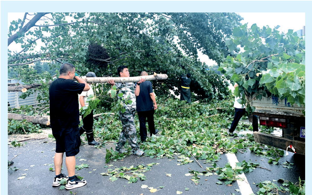
7月29日,受强降雨天气影响,市区黄河西路出现树木倒塌、断枝情况。经济开发区建设管理部迅速组织工作人员进行抢险处置,开展清理搬运工作。目前,倒伏断枝已全部清理完毕,相关道路恢复正常运行。
