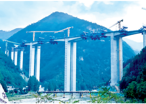
项目施工现场
