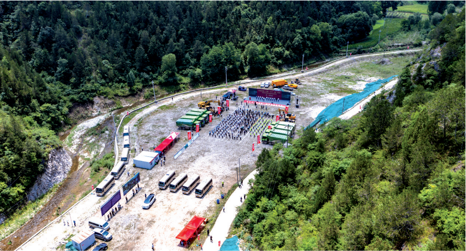
灵宝抽水蓄能电站项目开工仪式现场。该项目位于灵宝市朱阳镇境内,装机规模120万千瓦,年发电量约15亿千瓦时,年发电利用小时数1313小时,将对优化豫西地区能源结构、促进新能源消纳、保障电力安全运行起到重大支撑作用。 本报记者 孙猛 摄
