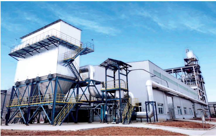
位于义马市的河南开祥化工有限公司年产1万吨电石渣制备硫酸钙晶须项目,一次性打通全流程并产出合格硫酸钙晶须产品,这也是国内首套正式投运的电石渣制备硫酸钙晶须装置。 蔡纹彬 摄
