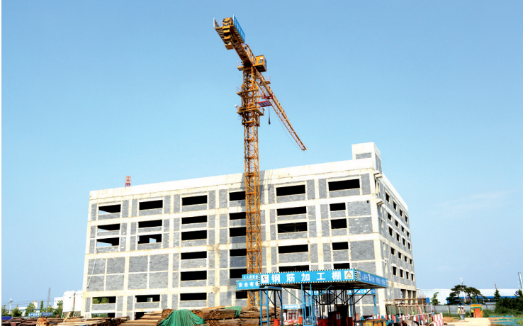
在位于三门峡经济开发区东区的三门峡赛诺维制药有限公司异地技改项目现场,施工人員正在新厂区内的综合仓库楼加紧施工。 本报记者 徐小龙 摄
