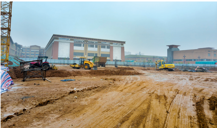
位于渑池县的仰韶酒业3.6万吨半敞开式不锈钢酒库项目正在施工中。该项目总投资8000万元,是仰韶酒业提质增效的重点工程。刘松 摄
