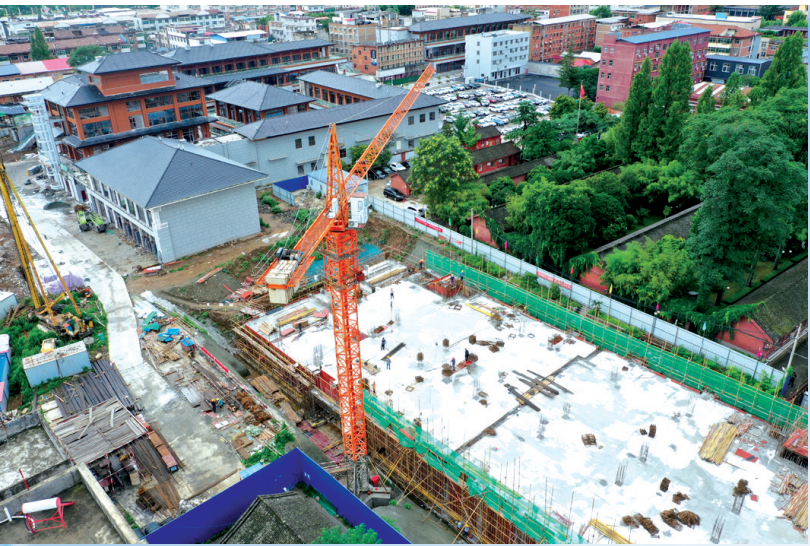
在卢氏县莘川坊项目建筑工地,工人正忙着施工,抢抓工期。 聂金锋 摄
