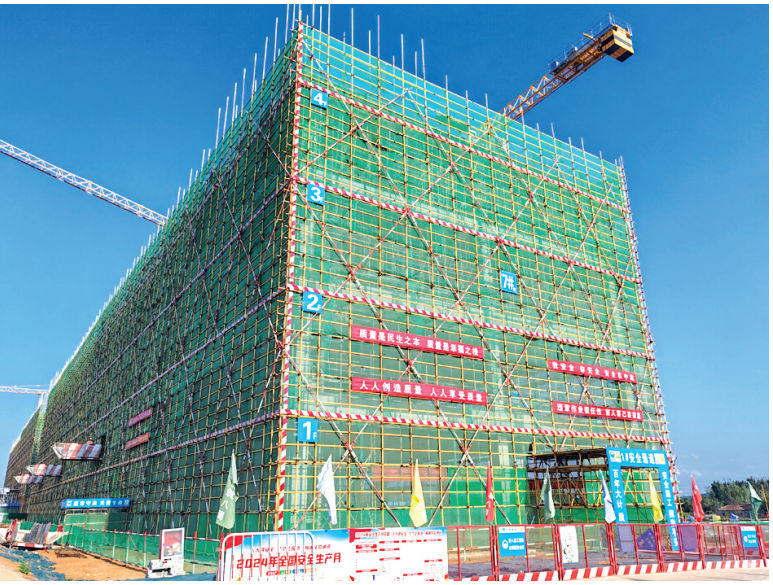
义马市电子信息产业孵化园建设项目(一期)正加快建设步伐。 平倩 摄
