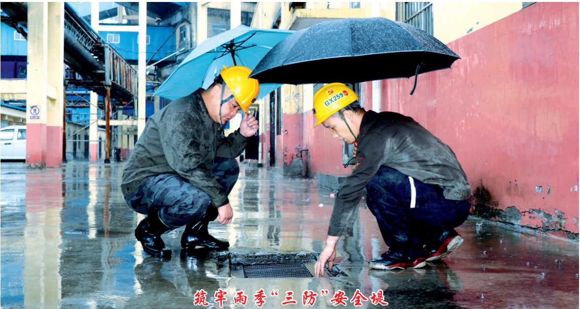
针对近期雨水较多的情况，河南能源义煤公司耿村煤矿本着早部署、早检查、早处理的原则，扎实开展雨季“三防”专项检查。图为该矿雨季“三防”专项检查组冒雨对洗煤厂排水通道进行检查。 杨静娟 摄
