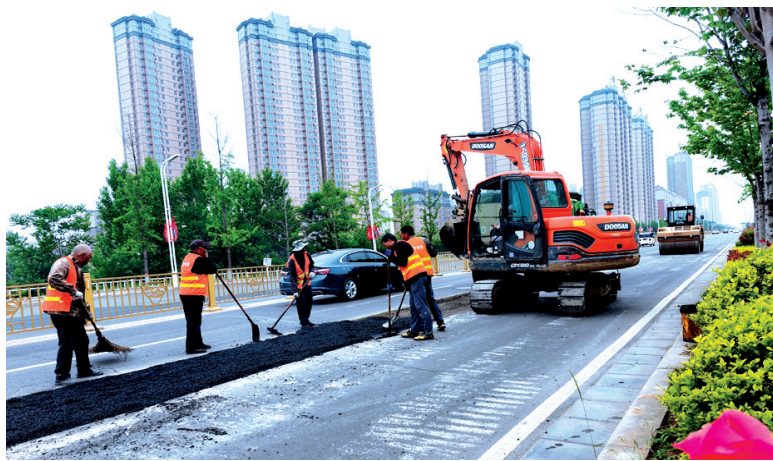
连日来,池池县城市管理局组织市政人员对各个干道进行全面检查,维修路面坑槽,排除安全隐患,确保群众“五一”期间安全出行。陈旭 摄
