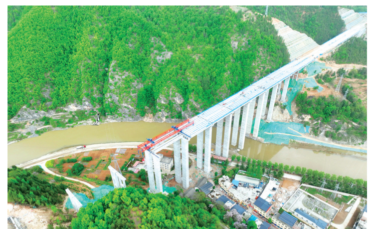
建设中的徐家湾洛河大桥 刘润华 摄
