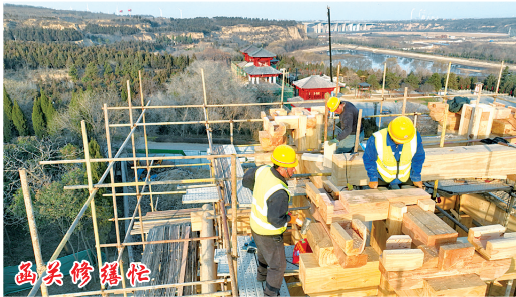
1月11日,工人在函谷关历史文化旅游区修缮提升工程施工。该工程在翻新关楼、修建望气台时,采用古法榫卯结构,重现函谷关紫气东来故事,预计春节期间向游人开放。 段景波 摄
