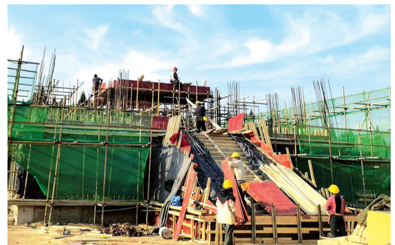
望气台项目建设进行中
