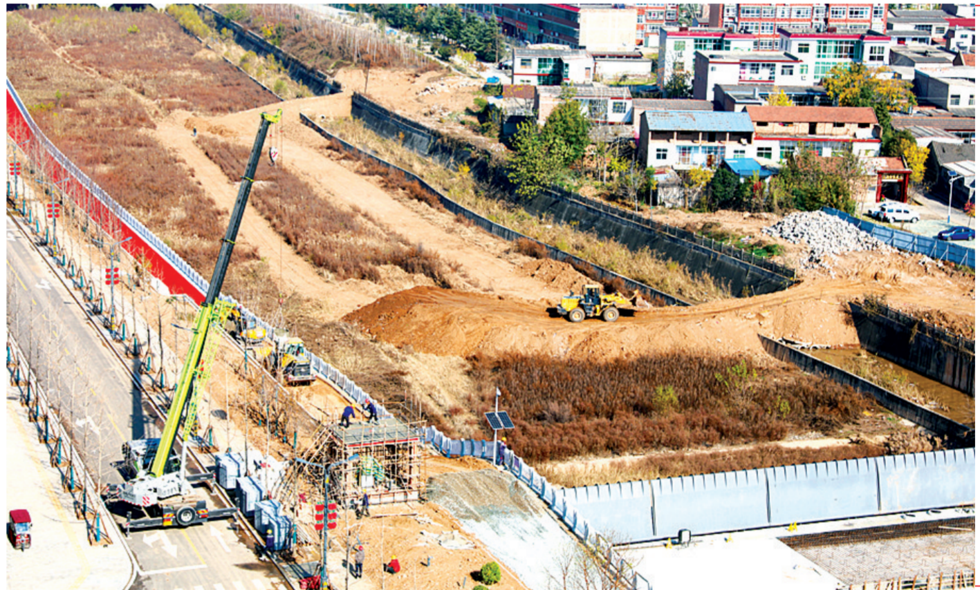
11月28日,工人在灵宝市新密河河西滨道路上忙碌施工。灵宝市新密河滨路工程预算6000余万元,改造建设观景台、停车场、景观道路等,今年年底主体建设将完成。不久,该市将增加一条绿色景观道路,既提高了城市绿化率,又为市民增添了好去处。 段景波 摄
