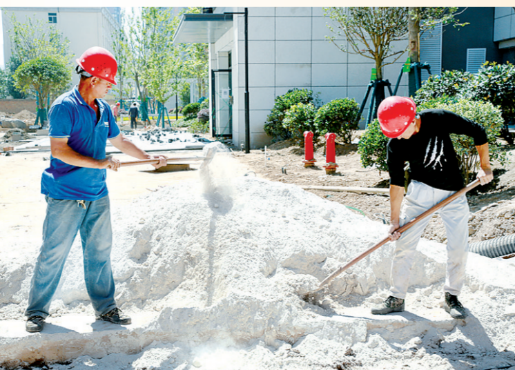
7月8日,为应对高温酷暑天气,建筑工人带着舒适透气的安全帽、衣着宽松进行施工。同时,合理安排施工作息时间,适当调整施工班次,避免高温时段作业。 本报记者 宋杰 摄
