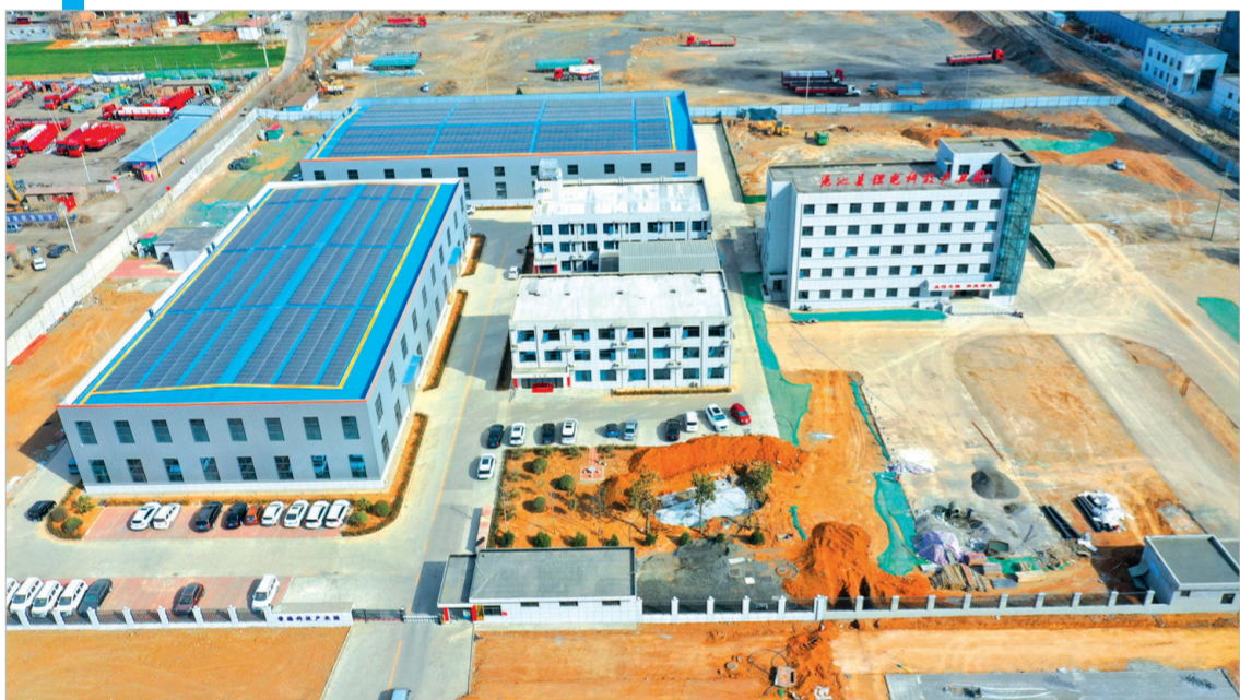
渑池县锂电科技产业园项目二期 王鑫 摄
