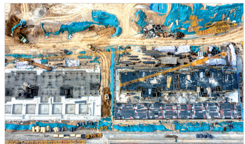
会兴安置房建设加快进度
