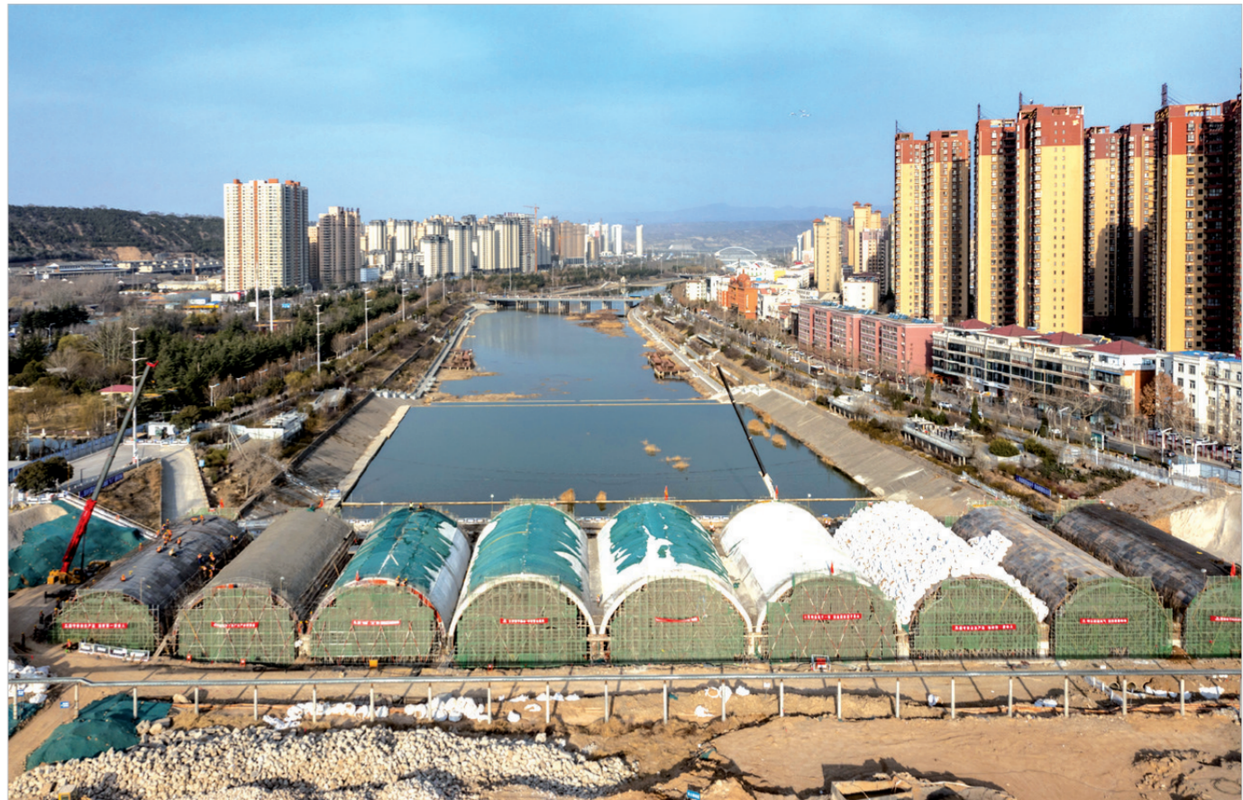
九孔玉带桥建设进入关键阶段
